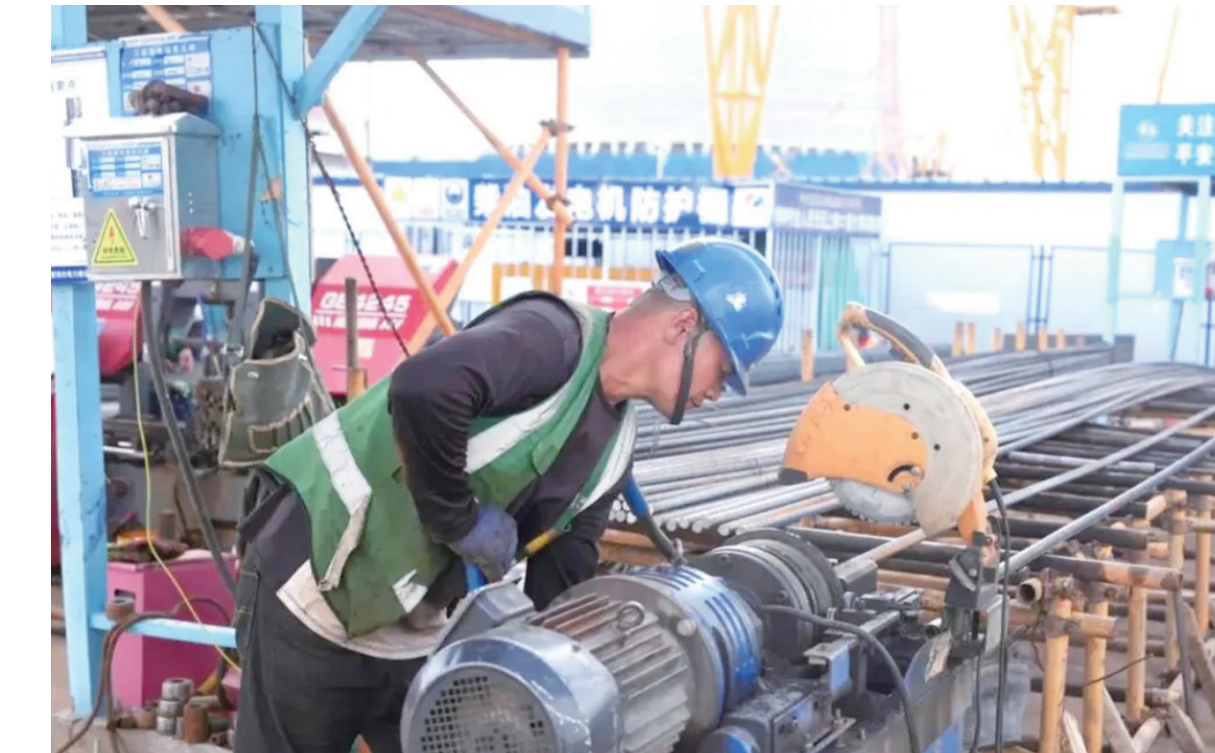
盛夏酷暑,热浪滚滚。我市各重大项目施工现场一派繁忙,大型机械轰鸣,施工人员不畏高温、奋战一线,铆足干劲赶进度、保质量,以实干攻坚助推全市重大项目落地见效,为高质量发展注入强劲动能。图为近日,位于达拉特旗的三峡集团库布齐中北部新能源基地400万千瓦配套支撑性煤电项目建设正酣。
