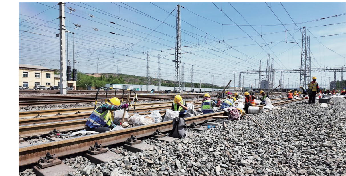
汛期临近,国能新朔铁路围绕西煤东运主通道,统筹人防、物防、技防和工程措施,确保亿吨级能源通道安全。图为工人们正顶着烈日,对线路进行注浆加固。
