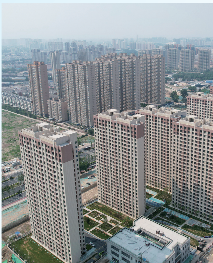
这是2025年5月26日拍摄的河北省保定市城中村改造三期工程南刘各庄村安置区楼房。“十四五”时期，我国建设筹集各类保障性住房和城中村、城市危旧房改造等安置房1100多万套（间），累计改造城镇老旧小区24万多个。 新华社记者 杨世尧摄
