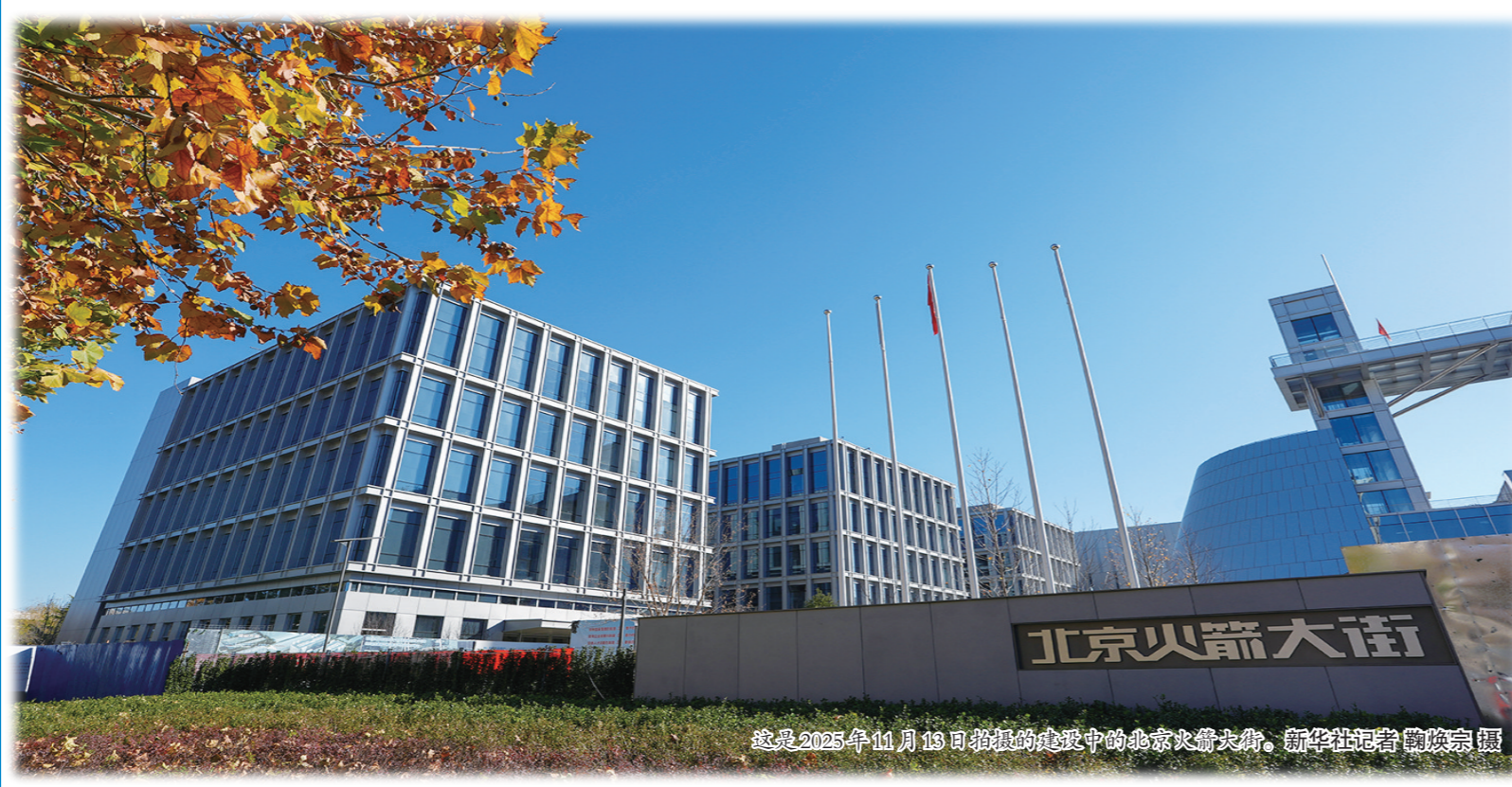
这是2025年11月13日拍摄的竣工中的北京火箭大街。新华社记者 顾晓宗 摄
