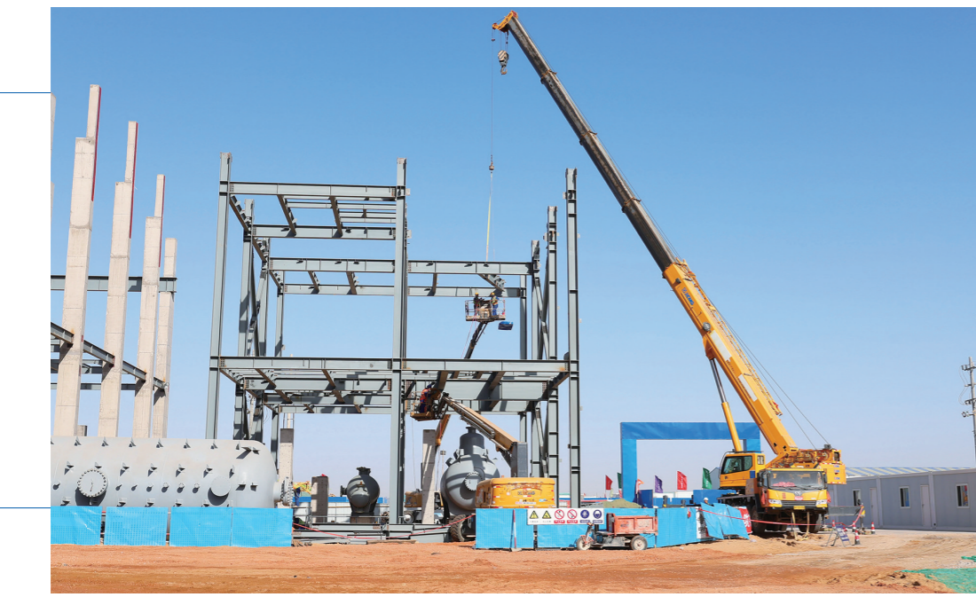
项目建设是经济社会发展的“压舱石”。连日来，我市各重大项目全面掀起大干快上的奋进热潮，建设者们抢抓进度、保质量，开足马力跑出施工“加速度”，绘就出一幅幅实干争先的生动图景。图为近日，内蒙古汇能卓正煤化工有限公司2026年第一阶段“百日会战”正式启动。 屈尘 吕赵腾 摄
