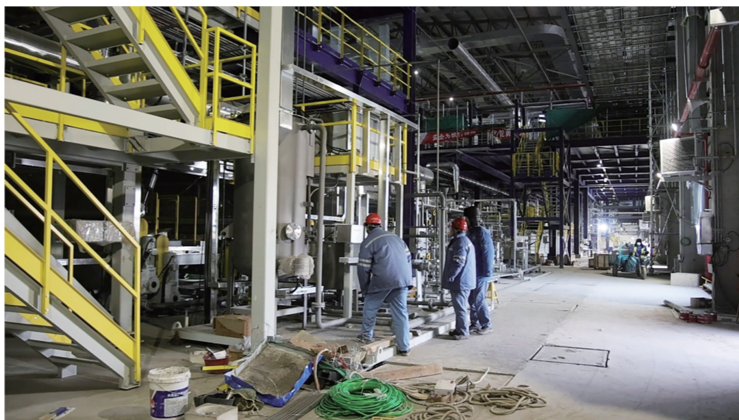
春节期间,内蒙古新金山碳纤维有限公司施工现场一派繁忙。工作人员坚守岗位,全力推进管道安装、设备调试等工程建设。
