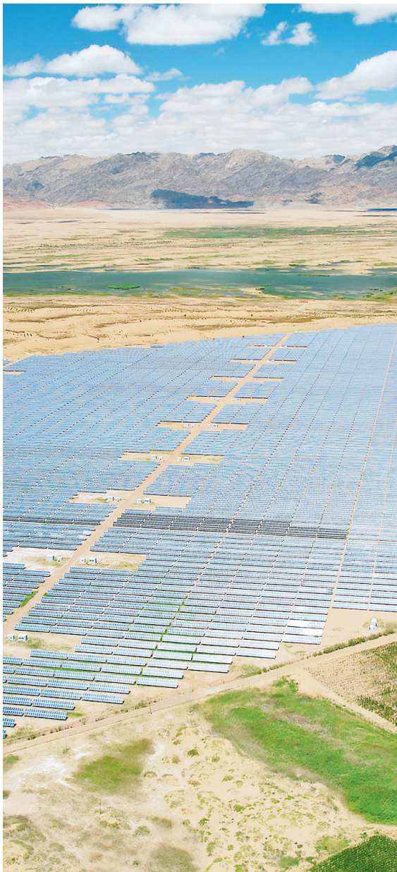
大漠光伏电站
