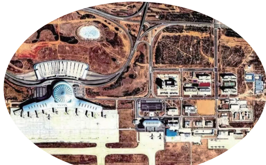
北京大学鄂尔多斯能源研究院“风—光—储—冷—热—电一体化‘零碳’机场项目”
