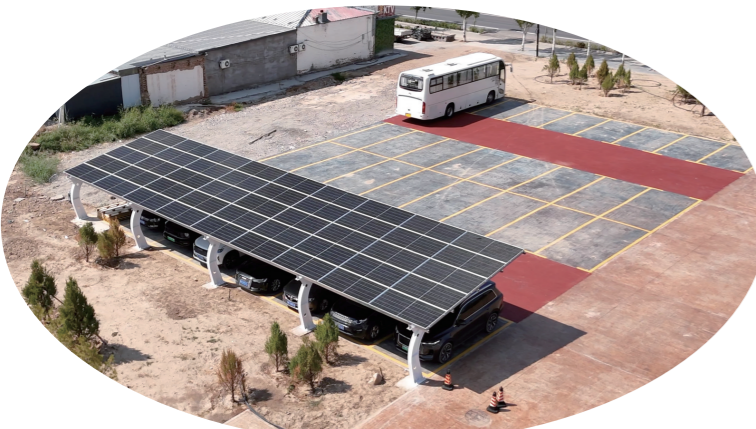
公司一次性向格更召嘎查捐赠资金78.75万元,推动屋顶分布式光伏项目、光伏储能车棚近电产业项目并网发电
