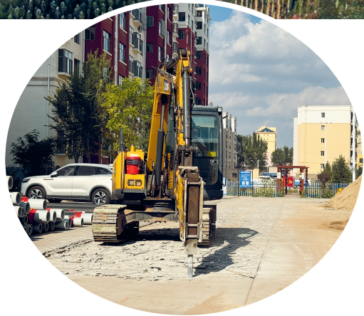
二次供热管网破除路面施工现场
